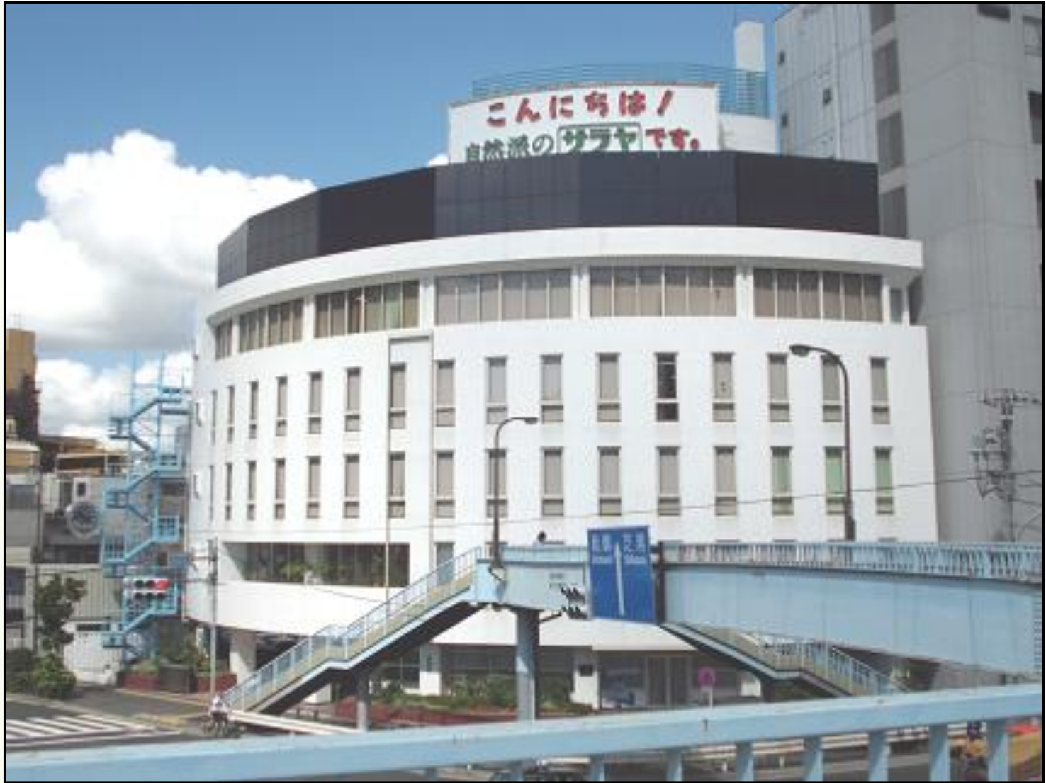
東京サラヤ本社 最上階に太陽光パネルと風力発電を設置
