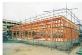
工事中の店舗
